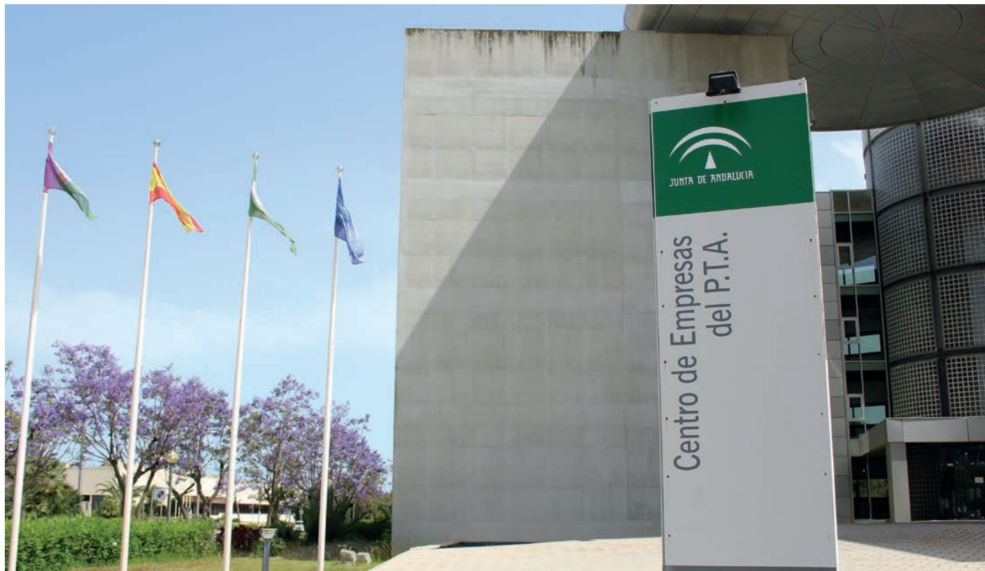
Entrada principal de la sede administrativa de la tecnópolis malagueña dependiente de la Junta de Andalucía. /J. L. J.
