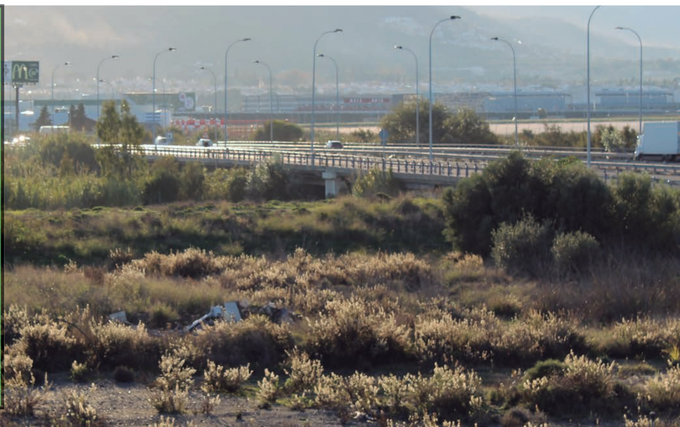
El puente de La Azucarera es la principal infraestructura que se debe modificar para acabar con la inundabilidad. /J.L.Jiménez
