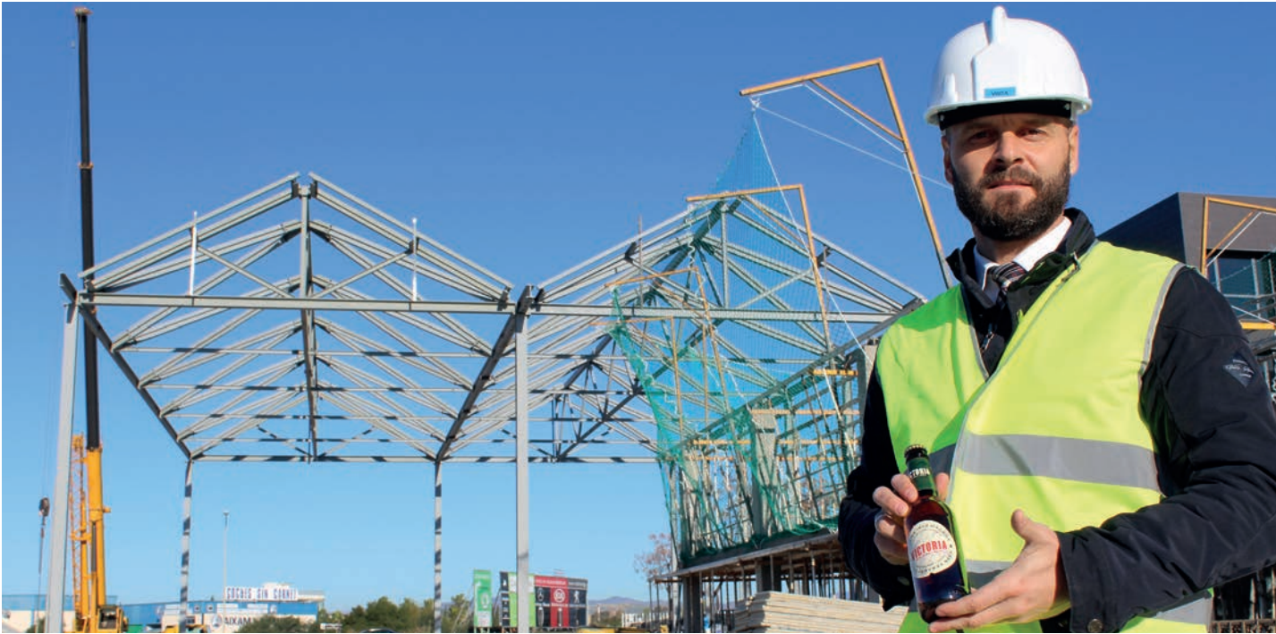
Ragel, que es responsable de marketing de Cerveza Victoria, posa en la obra de construcción de la futura fábrica. /J. L. J.
