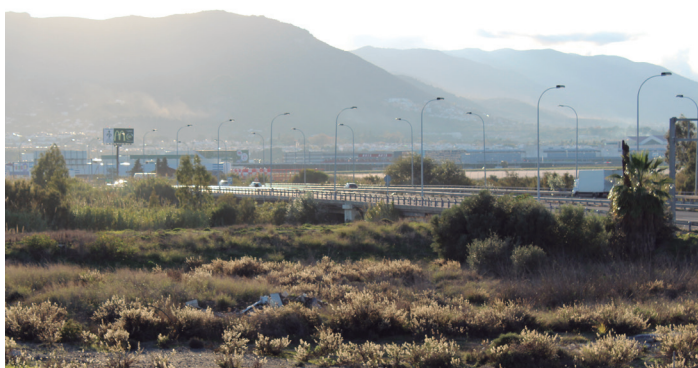
Aspecto actual del puente de La Azucarera. /J. L. J.
